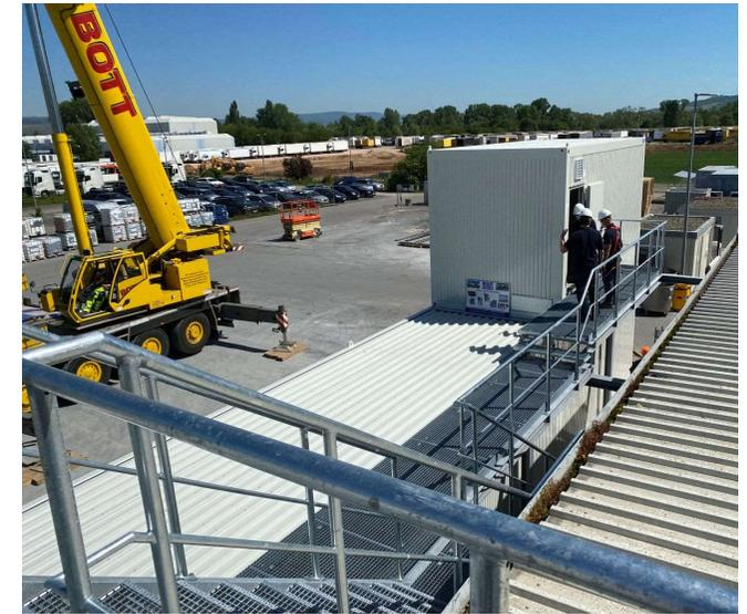
**4x WRT-CONTAINER inkl. kplt. Stahlgerüst + Treppenaufbau + Übergang in Bestandsgebäude**
