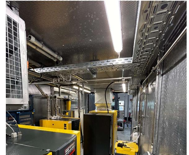
20' – STAHL-Container inkl. Schalldämmung –
